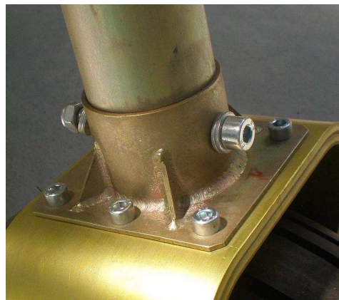
Obr. 2: Príruha so zosilňujúcimi rebriami
